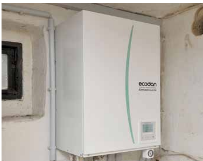
Hydromodul zajišťuje efektivní přenos energie z chladiva do topné vody
