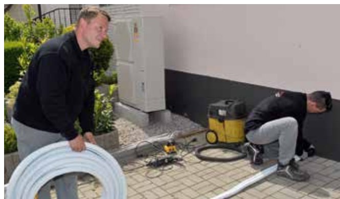
Pro připojení modulů tepelného čerpadla je ve stěně zapotřebí vybudovat jen malý průřez
